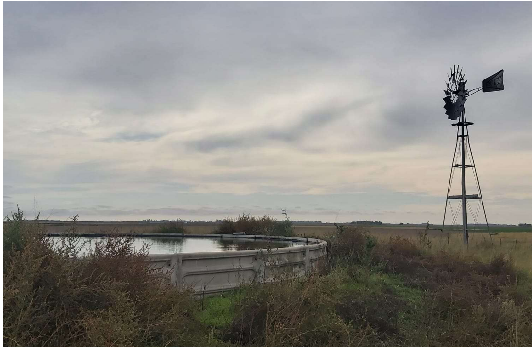
Imagen 2. Tanque con molino lote 2
