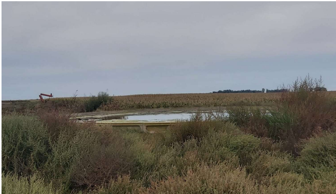
Imagen 1. Tanque con molino lote 3.
